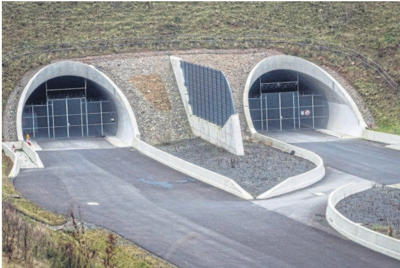
Größtes Projekt im Landkreis: Die Autobahn 40 wird von Kassel bis zur Autobahn 5 bei Gemünden ausgebaut. Im Bild oben ist der Tunnel Frankenhain zu sehen. In der Grafik unten die Ausbaustrecke.
