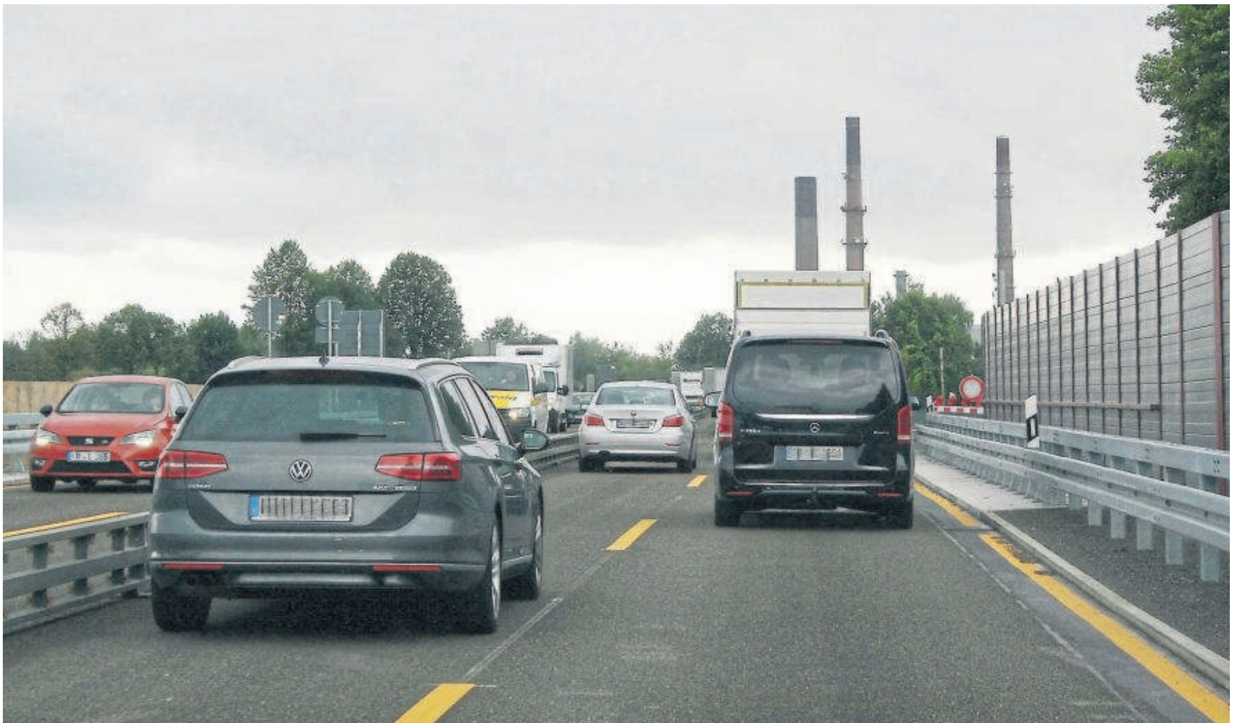
Seit Jahren ein Nadelöhr: Die Brückenbaustelle auf der A 49 bei Baunatal-Nord. Verkehrsteilnehmer kritisierten jetzt, dass auf der Baustelle über einen längeren Zeitraum keine Arbeiter zusehen gewesen seien. Hessen Mobil dementiert dies. Archivfoto: Sven Kühling
