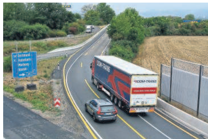
Zweispurige Ausfahrt auf die A49: Um die Bergshäuser Brücke zu entlasten, wird der A7-Verkehr Richtung Dortmund ab Kassel-Mitte über die A49 geleitet.
