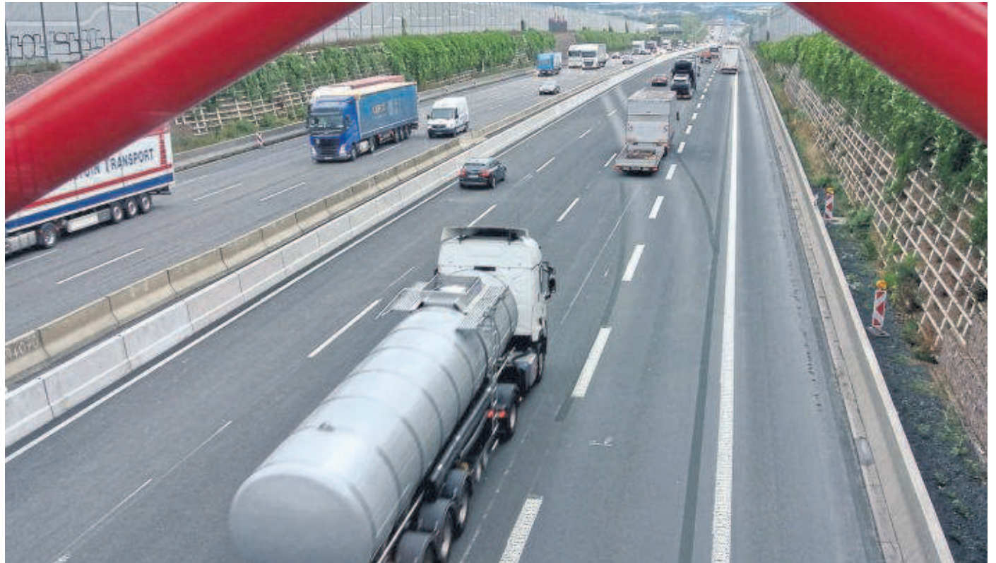
Jetzt fertig: Der vierstreifige Ausbau der der A7 in Fahrtrichtung Süden hat gut zwei Jahre gedauert. Voraussichtlich im Frühjahr 2019 wird dann der vierstreifige Ausbau der A7 auf der Gegenseite in Fahrtrichtung Norden in Angriff genommen. Der Ausbau der A7 steht im Zusammenhang mit dem Weiterbau der A44 von Kassel-Ost in Richtung Osten bis zur A4 bei Herleshausen.
