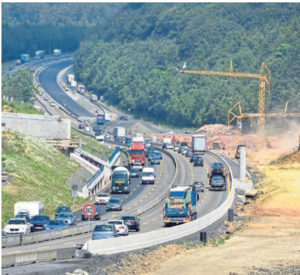
Falschen Belag verbaut: Als die Helterbachtalbrücke 2014 erneuert wurde, verbaute Hessen Mobil keinen Flüsterasphalt.
